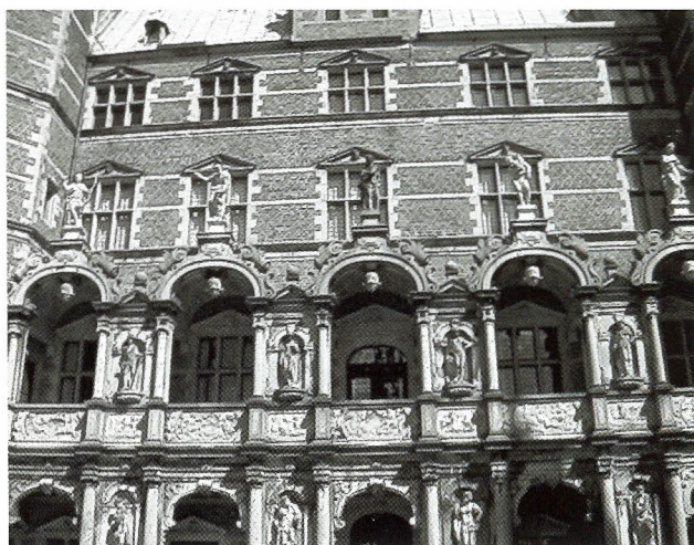
Slottet er bygget i nederlandsk renæssancestil i begyndelsen af 1600-tallet af Christian IV – og genopført efter en ødelæggende brand ca. 250 år senere af en anden stor dansker, brygger J.C. Jacobsen. Her er midterfløjens facade set fra gårdspladsen.
