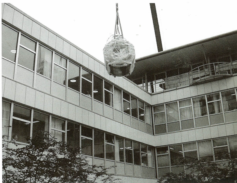
MR magneten til Odense Universitetshospital bringes på plads.
