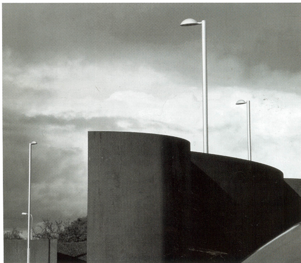
På Randers Ringboulevard kan Milewide-armaturerne og de specialdesignede master ses i sammenhæng med bl.a. de viste støjskærme.
