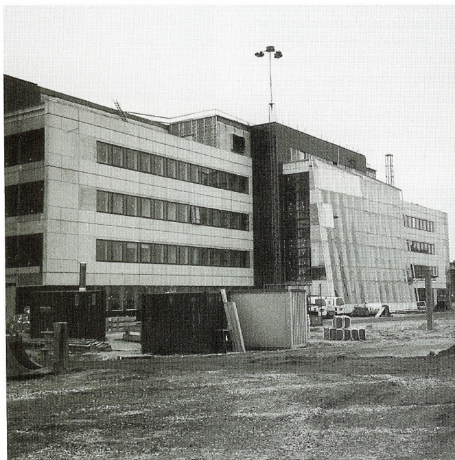
Indgangspartiet er netop kommet under tag, men endnu er det svært at se, hvor døren skal være. På nær de midlertidige krydsfinerplader ligner sydfacaden dog snart sig selv.
