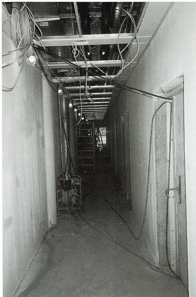
Loftet over den lange gang i stueetagen er endnu utildækket, og ledninger hænger ned overalt. Den midlertidige belysning er en minegang værdig...
