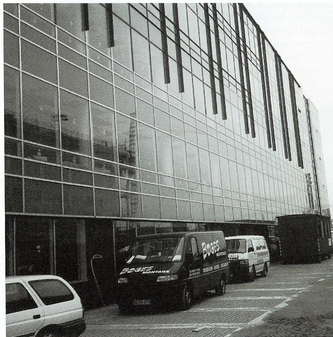
Nordfacaden med sin curtain wall glasvæg er ved at se færdig ud. Dog mangler endnu den nederste del af de lodrette skinner på facaden.
