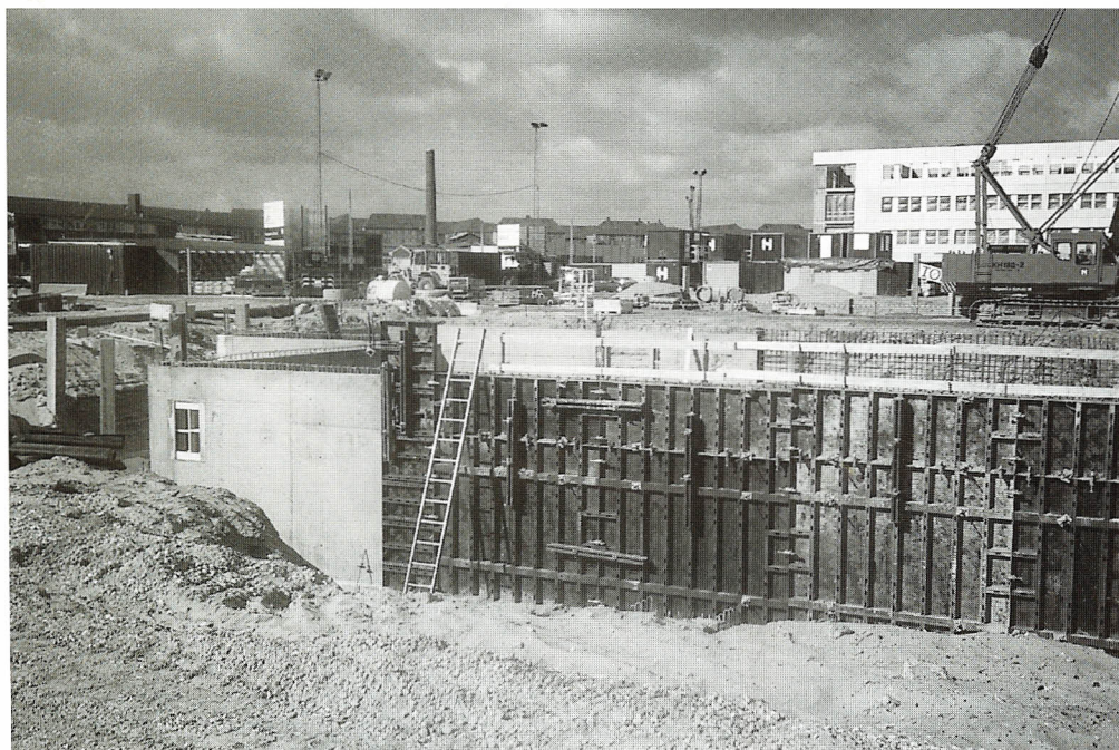
Hvor der ved juletid kun var et hul i jorden, er det nye Philips-hus nu på vej op af jorden. Her ser man den næsten færdige kælder, som er udvidet i forhold til de oprindelige planer.
