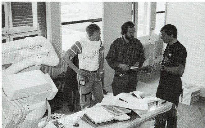
Peter Åby Jensen, Niels Wittenwiler og Gustav Struck fra Philips Medico er her ved at installere det nye INTEGRIS røntgenanlæg på første sal i Rigshospitalets østfløj.
