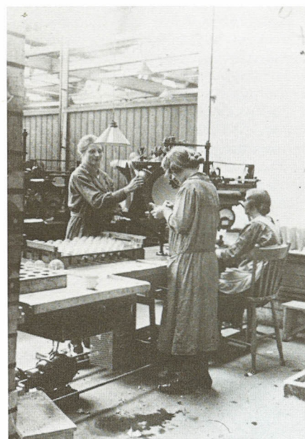
I de første år foregik fremstillingen af glødelamper fortrinsvis med håndkraft.
