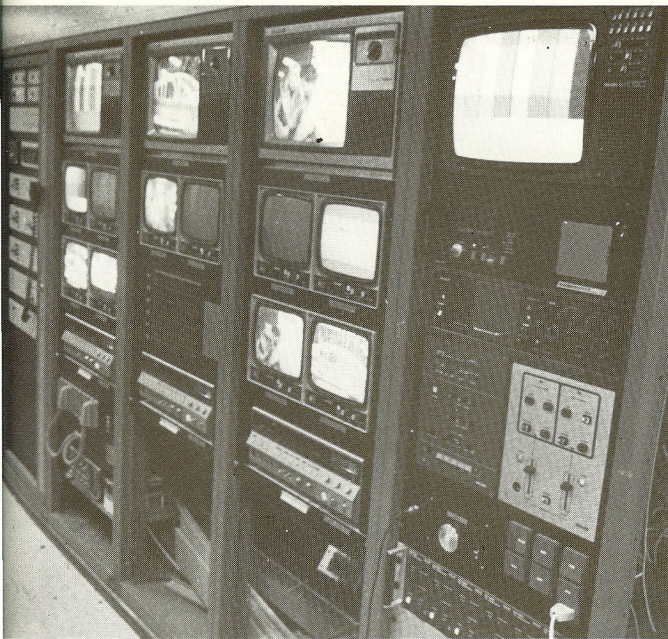
Verner Kejser, I&E, i det imponerende kontrolrum for elektronikken.
