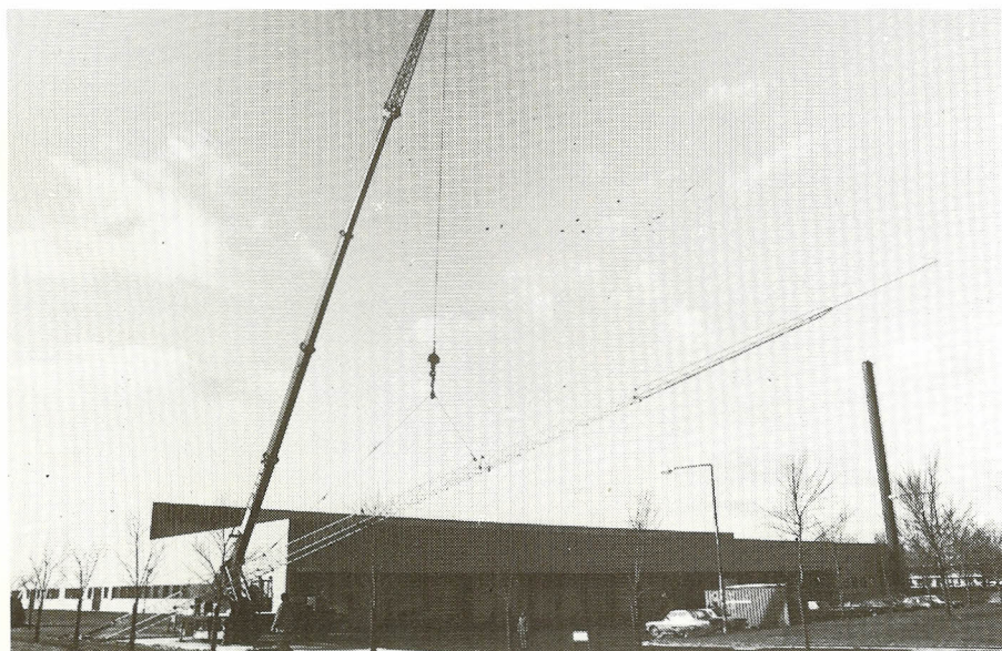
Der skulle en forsvarlig kran til at rejse den lange radiomast foran Centrallageret. Masten skal sikre effektiv radiokommunikation mellem kørselsafdelingen og selskabets lastvogne.
