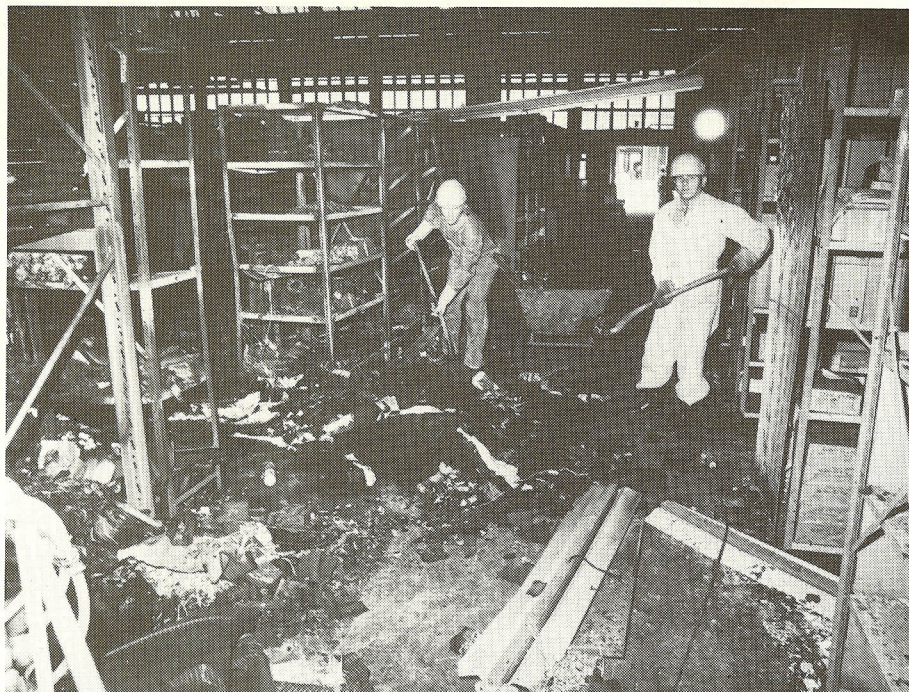
Allerede dagen efter branden gik man igang med oprydningsarbejdet i den brandskadede lagerbygning i Jenagade.
