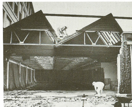
Håndværkere i fuld gang med at rive to sektioner af den gamle glødelampefabrik ned.
