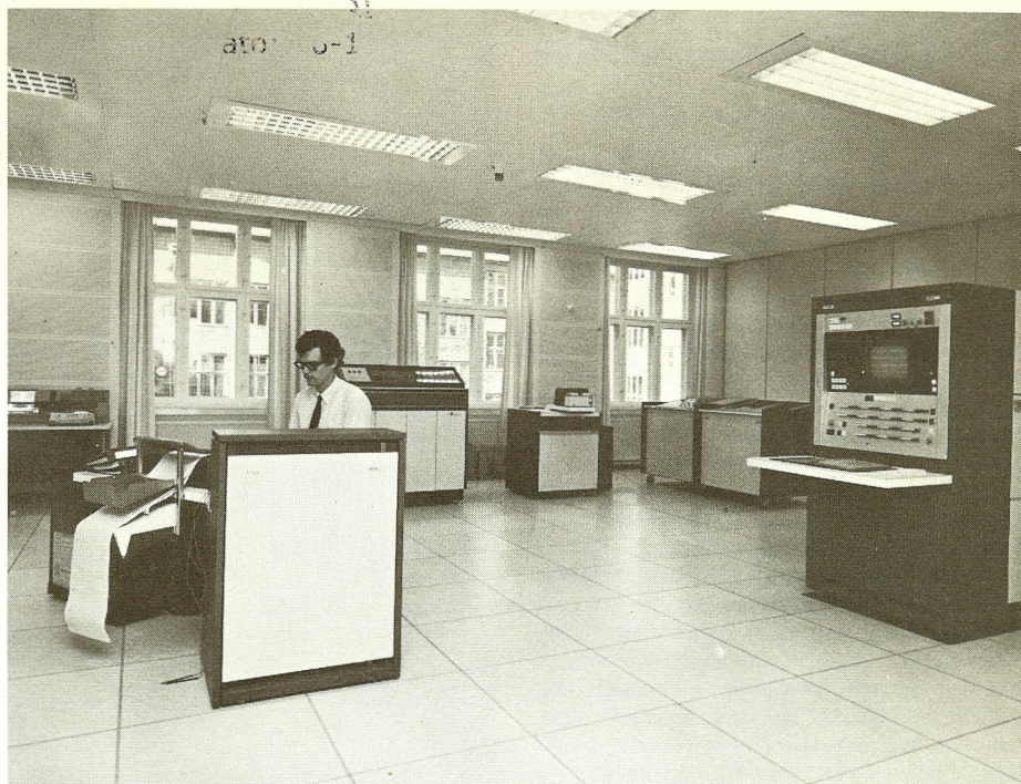
Et udsnit af datacentralen på Industrigården, hvor den store datamaskine P 1200 er installeret og snart tages i brug af edb-produktionsafdelingen. I loftet skimtes en af de små røgdetektorer, der er i direkte forbindelse med brandvæsenet. Detektorerne er så følsomme, at blot en beskedne mængde cigaretrøg kan aktivere dem.
