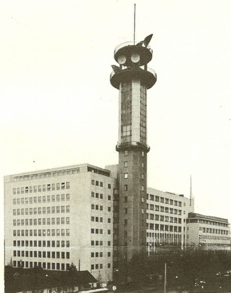
Telefonhuset i Borups Allé, hvor radiokæden har sit ene endepunkt.
