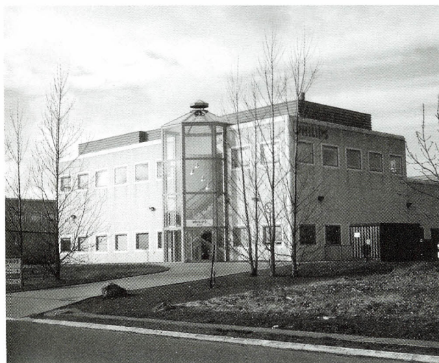
Armaturmonteringen har til huse i denne bygning i Hedehusene.
