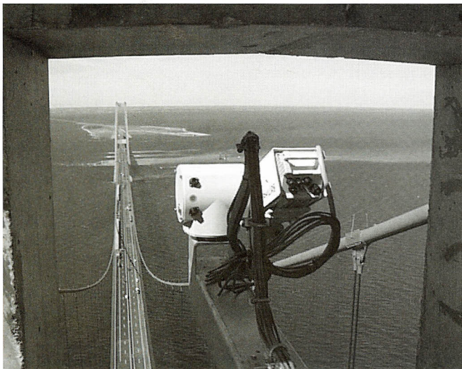
Udsigten over det midterste brofag fra toppen af Østpylonen. Der er 200 meter ned til kørebanen og 250 meter til vandet - læn Dem ikke ud! I forgrunden ses et af Philips overvågningskameraerne.
