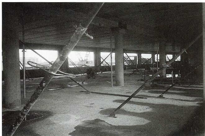
Et kig ind i stueetagen, som den så ud i starten af juni. Foreløbig er det hele rå beton, men planerne for både gulve, lofter og skillevægge er nu ved at være på plads.
