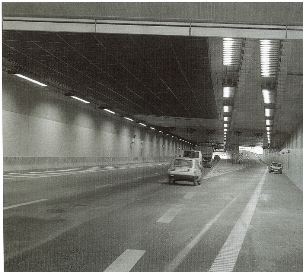
Projektet for tunnelarmaturer til Tårnby Overdækningen over den nye Øresundsmotorvej blev af koncernen belønnet med en Honourable Mention for et godt belysningsanlæg.
