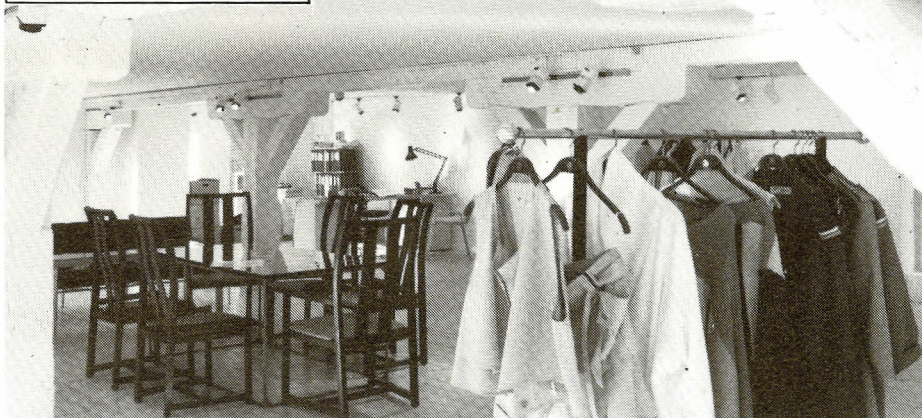
Til Margit og Erik Brandts kunst- og designcenter i et af de 300 år gamle pakhuse ved Christianshavns Kanal er leveret et belysningsanlæg med nye halogen-spot med 50 watt reflektorlampe.
