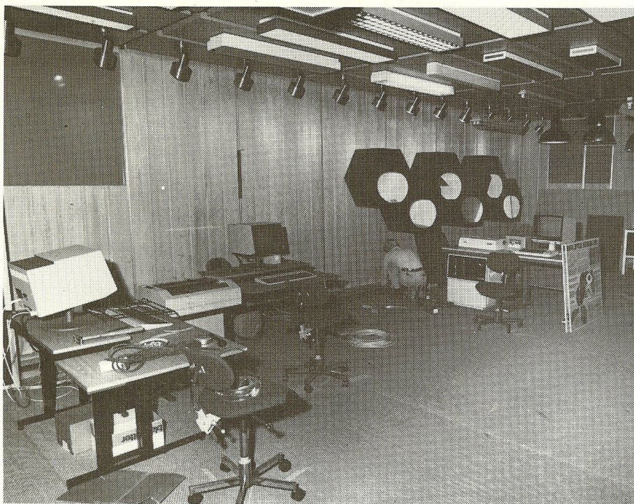
Elektrikerne var i fuld sving med at få de sidste installationer bragt i orden i det nye fælles demonstrationslokale på Graham Bells Vej.
